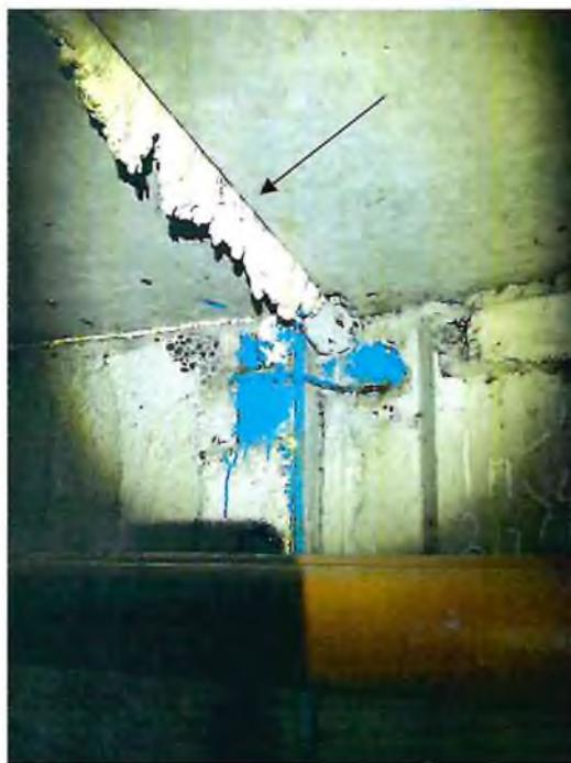
Фото № 16,17. Пустые стыки плит перекрытий, запененные жильцами. Вместо пластины использован пруток.
