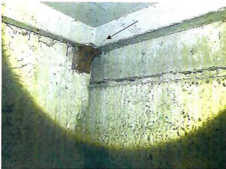
Фото №25. Отсутствие антикоррозийной обработки закладных.
