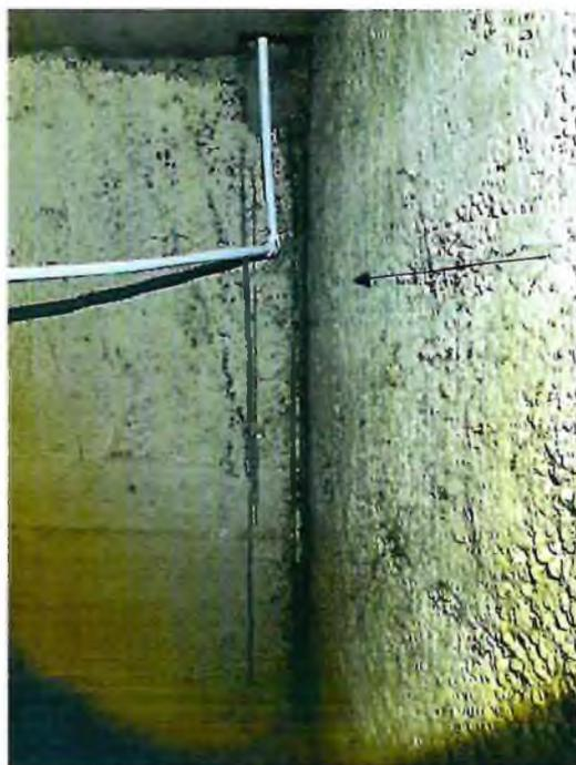
Фото № 18,19. Вместо пластины использован пруток. Вертикальный стык не забетонирован.
