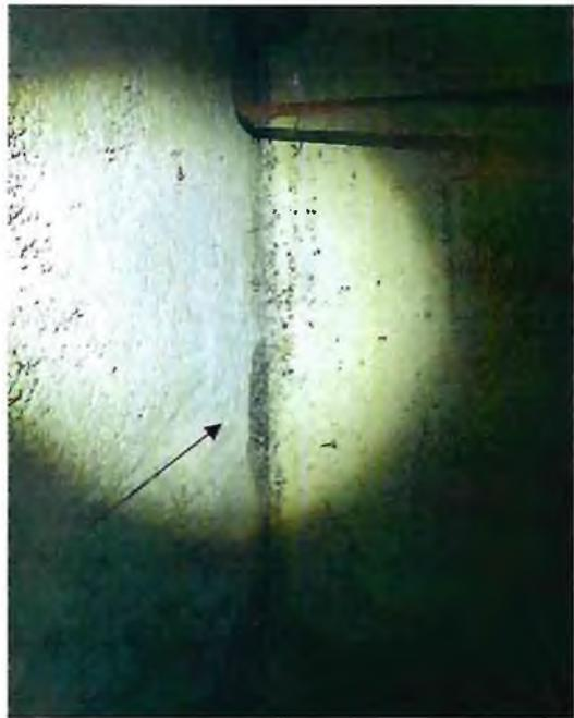
Фото № 20,21. Вместо пластины использован пруток. Вертикальный стык забетонирован керамзитом.
