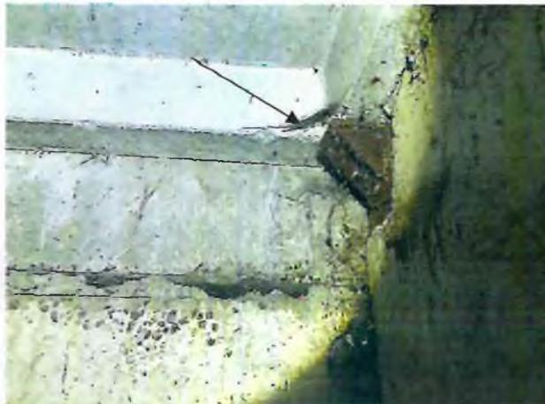
Фото №24. Отсутствие антикоррозийной обработки закладных.
